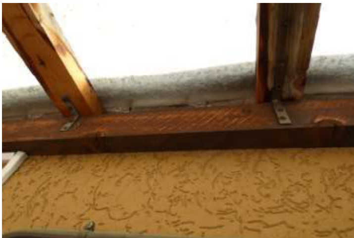
Foto 10 I listoni di legno con cui è realizzata la tettoia
