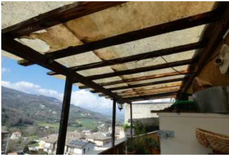
Foto 7 La tettoia realizzata sul terrazzo della cucina e del soggiorno
